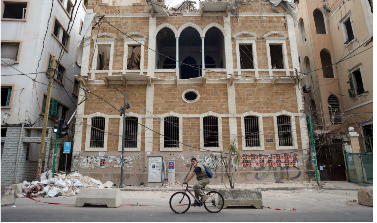
صورة: مبنى تراثي مدمر نتيجة حادثة انفجار ميناء بيروت © ٢٠٢٠ حسن شعبان | بلومبرغ
