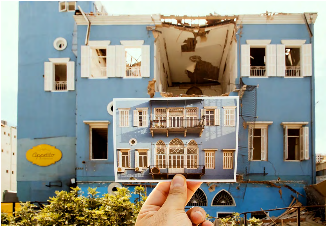
صورة: مجموعة مباني مدمرة نتيجة حادثة انفجار ميناء بيروت ٢٠٢٠ © ٢٠٢٤ جوزف خوري | @joekhourystudio | Project @bouyoutbeirut
