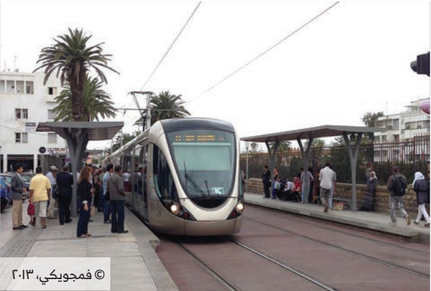
الشكل ٤,٦٠: ترامواي الرباط - سلا أثناء التشغيل.
